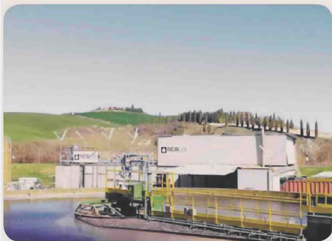
Impianto Newlisi di Siena
